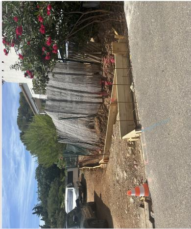
Coulage fondation confirmer cubage formule cadence avec client \_\_ATTENTION il y'a des rendants à faire ( blocage ) \_\_Béton S3 pour blocage et S4 pour la suite
